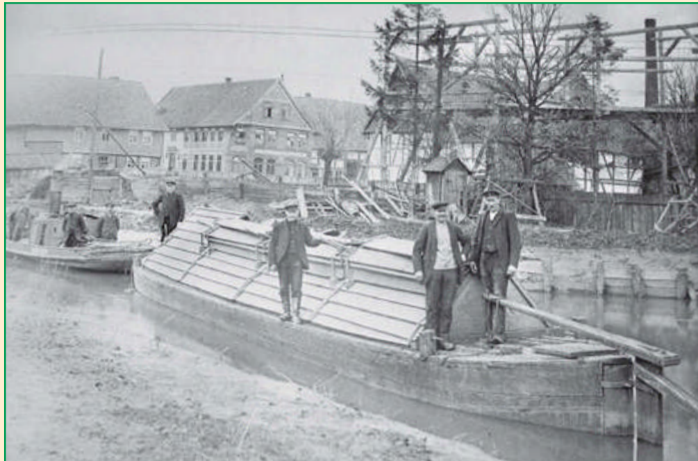
Der Sülbecker Hafen im Jahre 1909. Zwei dampfmotorenbetriebene Boote gab es zu der Zeit auf dem Salzgraben, die für den Transport des »weißen Goldes« zum Bahnhof nach Salzderhelden sorgten und mit Kohlen zurückkamen. Der Bau der Seilbahn ist auf der rechten Bildseite zu erkennen.
