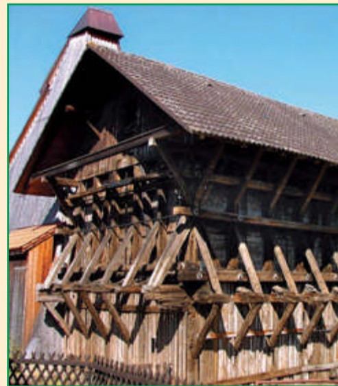
Das hölzerne Solereservoir von 1882.
